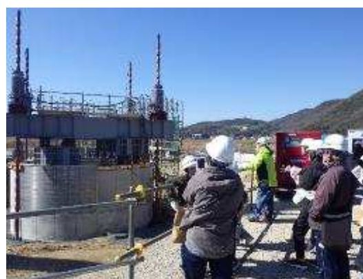
「工事現場見学会」
