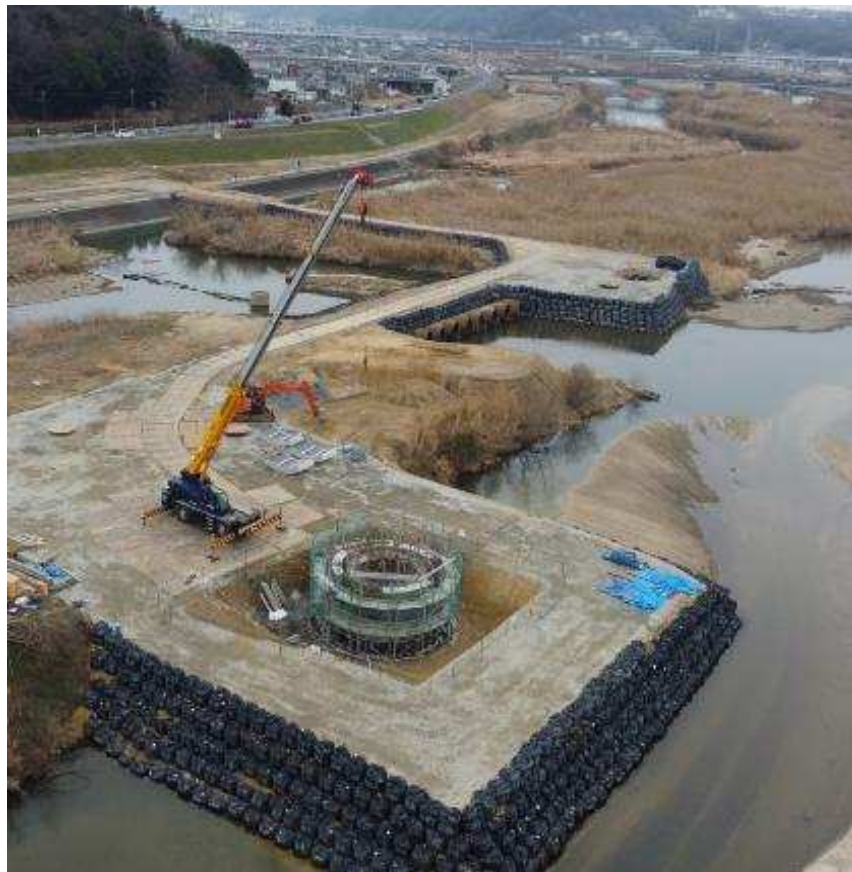
「出原浄水場1群3号井改築工事」
