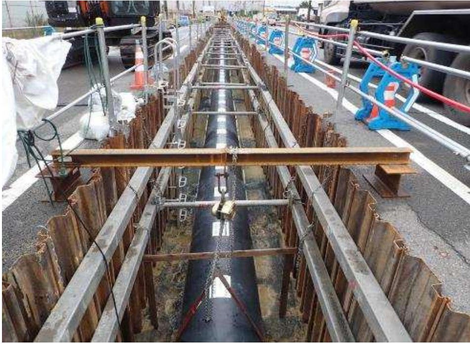
「配水管布設工事（工水配改5-5）」布設状況
