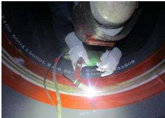
「配水管布設工事（工水配改4-3）」 鉄管溶接状況
