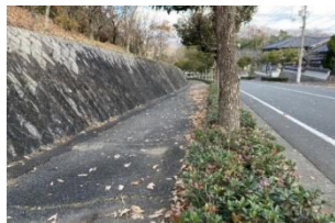
瀬戸進入路 作業前
