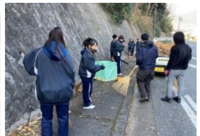
瀬戸進入路 作業風景
