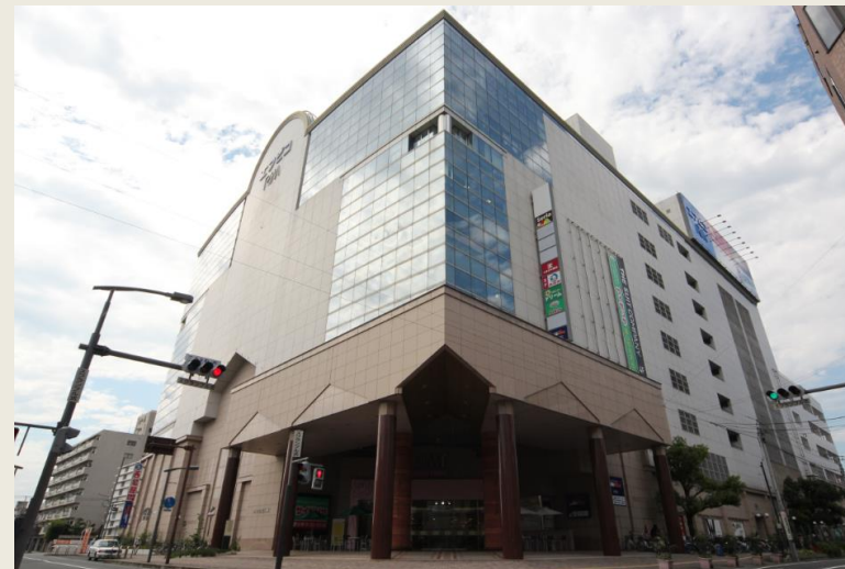
エフピコRiM（本館）の外観写真
