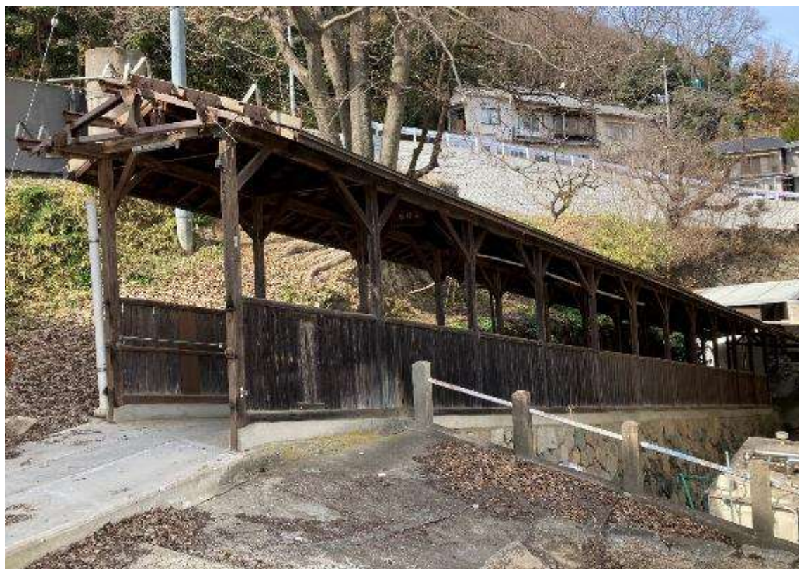
＜渡り廊下（解体予定）＞
