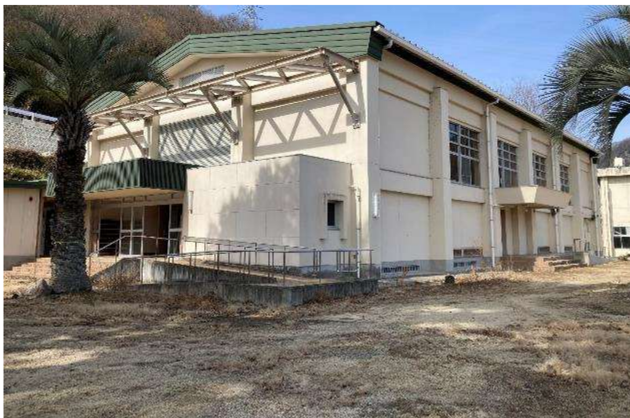
＜屋内運動場（解体予定）＞
