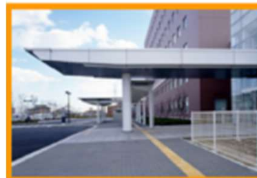
段差がなく、見通しの良いアプローチ通路 視覚障がい者誘導用のブロックの敷設
