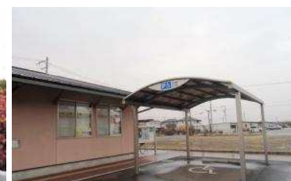
屋根が設置された 身体障がい者用駐車場
