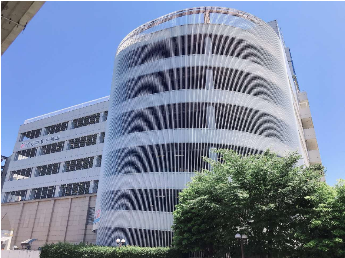
本館及び第1駐車場外観写真（北西から撮影）
