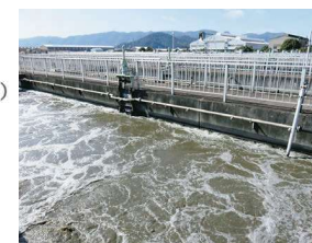
下水処理場 (芦田川浄化センター)
