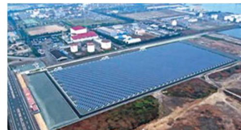
たいようこうはつでん せつち 太陽光発電システムの設置 福山太陽光発電所「メガソーラー」 (提供：中国電力株式会社)
