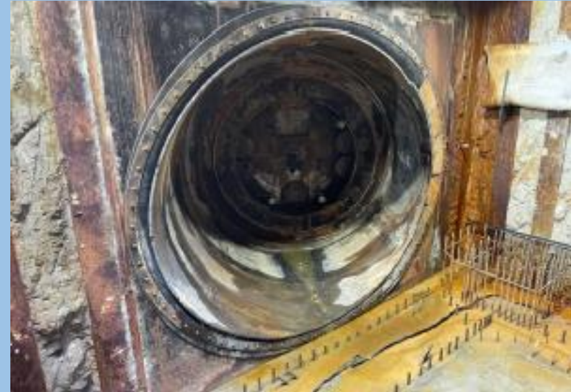
撮影地点① 雨水幹線とポンプ場の接続部分
