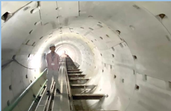
雨水幹線内部（管径3m）
