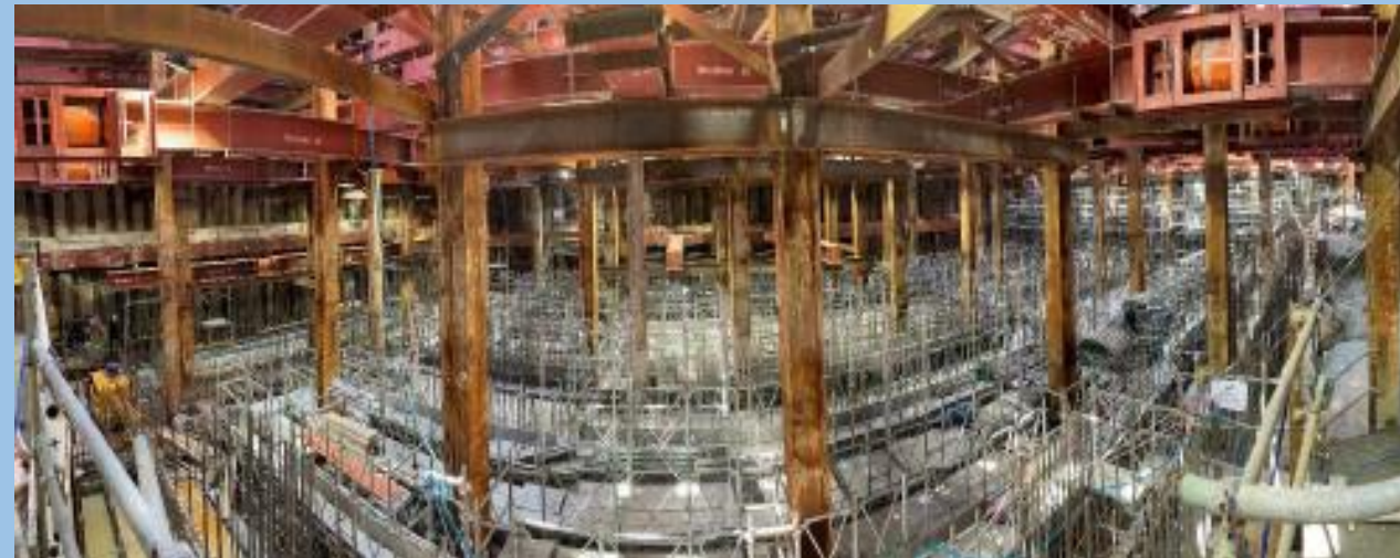
撮影地点② ポンプ場内部の水槽設置工事の状況
