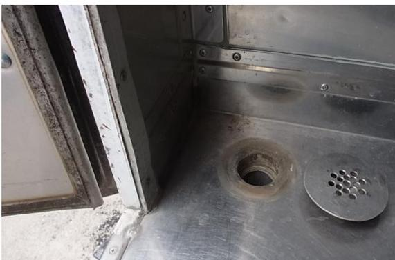
水抜き穴及びステンレス製の蓋
