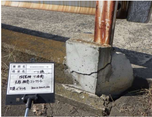
写1 下流起点側
