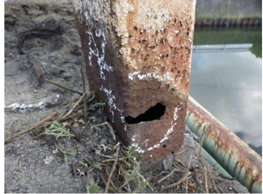
写2 下流終点側
