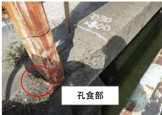
写3 下流終点側
