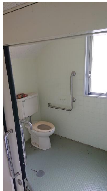
多目的トイレ
