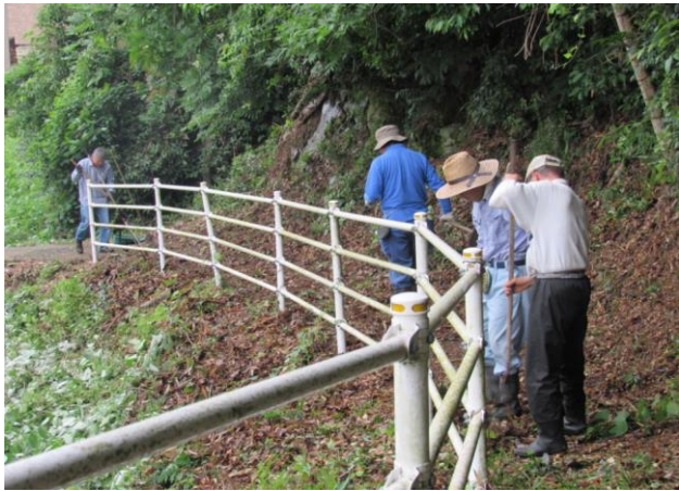
作業中：落葉の除去・草刈り
