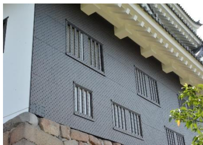
福山城天守北側の鉄板張り
