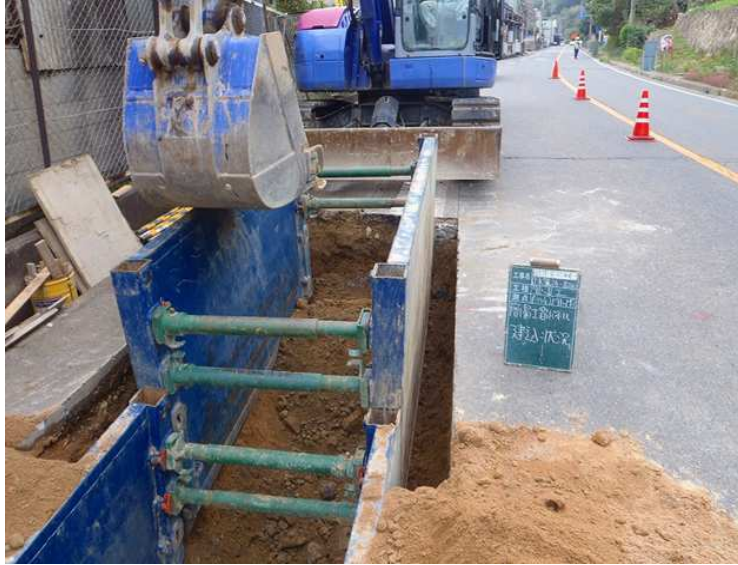
土留め設置状況
