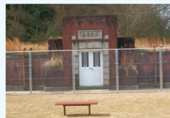
旧佐波浄水場配水池入口
