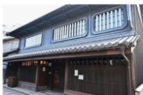
有形文化財(建造物)
