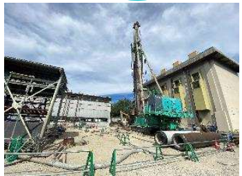
▲基礎杭施工状況
