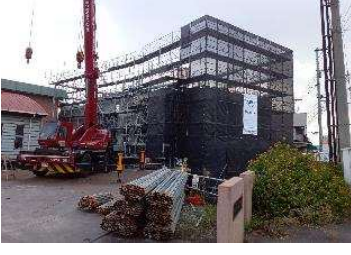
▲建築工事施工状況
