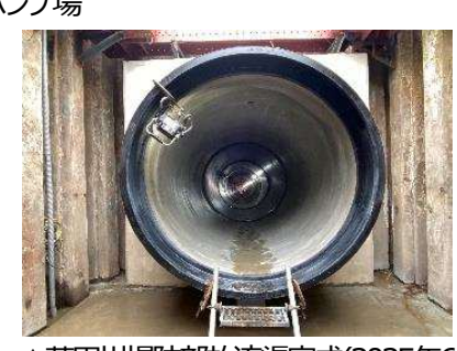
▲芦田川堤防部放流渠完成(2025年6月)
