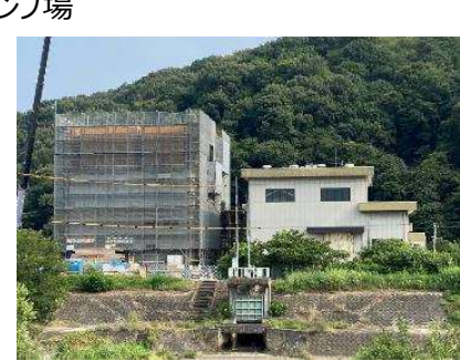
▲建築工事施工状況
