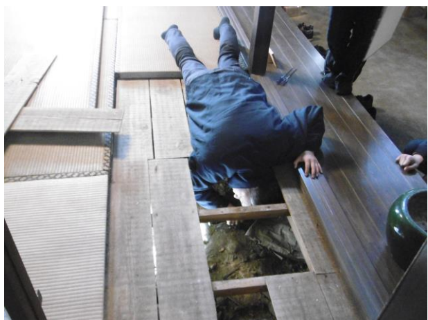
床下・基礎の調査
