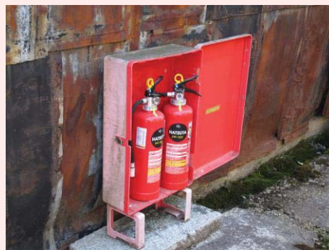
2本設置している事例
