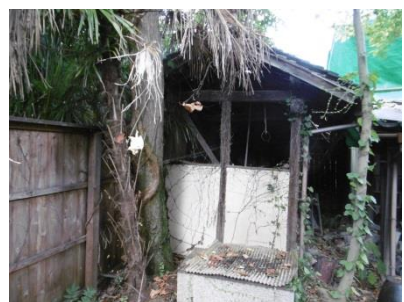
米搗小屋・物置・便所
