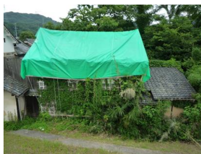
米蔵（シートによる養生）
