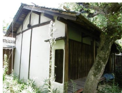
祠堂（シートによる養生）
