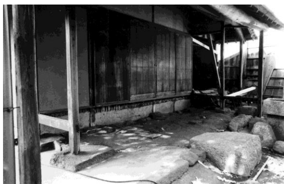
廉塾竹縁解体
