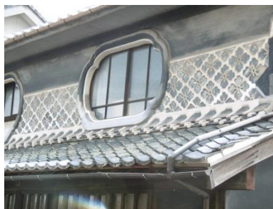
従前建物の部材（格子）を新築建物に利用。新築建物に伝統的な意匠を一部取り入れる
