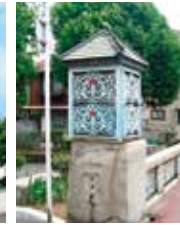
火と熱風で損傷した土橋 (吉津町)
