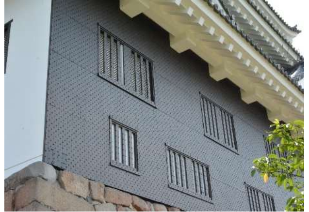
福山城天守北側の鉄板張り
