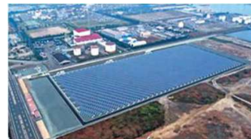
太陽光発電システムの設置 福山太陽光発電所【メガソーラー】 （提供：中国電力株式会社）
