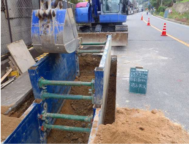
土留め設置状況
