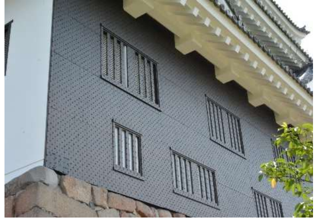
福山城天守北側の鉄板張り
