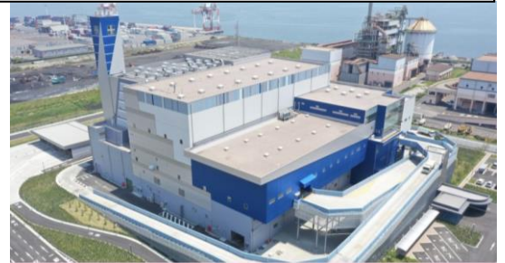
福山ローズエネルギーセンター
