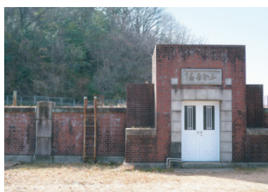
旧佐波浄水場 配水池 (国の登録有形文化財)
