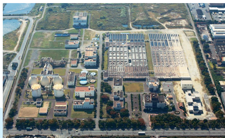
あしたかわじょうか 芦田川浄化センター
