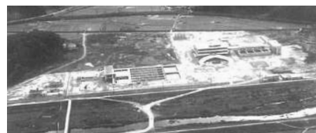
中津原浄水場の建設
