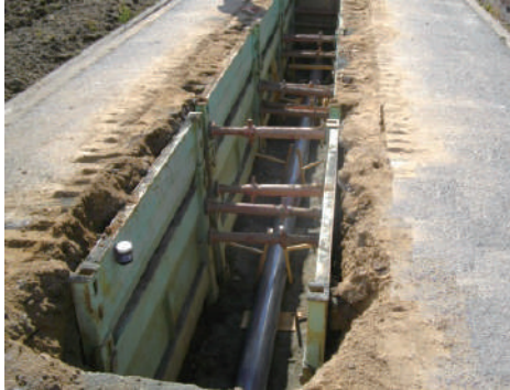
污水管渠施工状況(開削工法)
