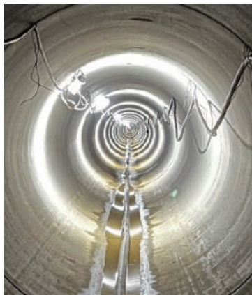
鉄筋コンクリート管内部
