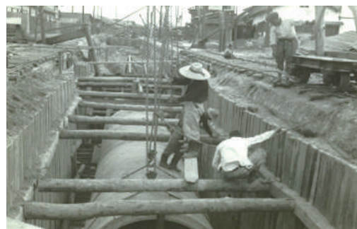
1953年(昭和28年) 下水道幹線の工事風景
