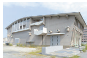
中央ポンプ場
