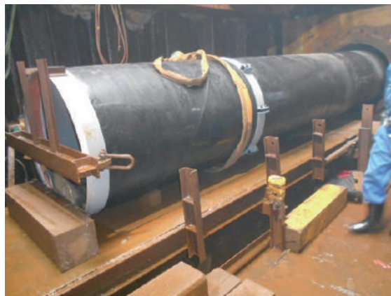
鋼管挿入状況
