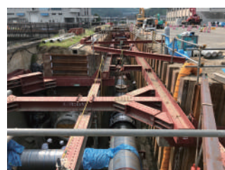
管路布設状況
