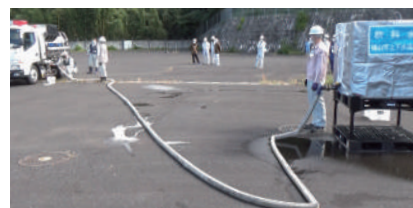
給水車から仮設水槽へ
