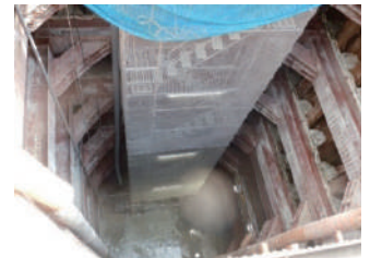
新浜町 発進立坑
