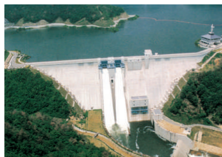
八田原ダム(八田原ダム管理所提供)
