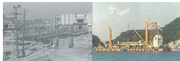
急速ろ過池の築造
