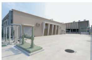
中央雨水滞水池
