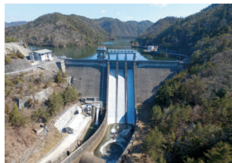
三川ダム(三川ダム管理事務所提供) ※ダム左下が小水力発電施設
