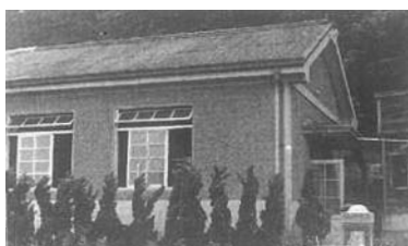
草戸ポンプ所
