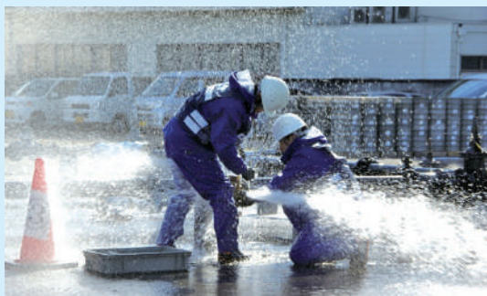
応急復旧訓練
