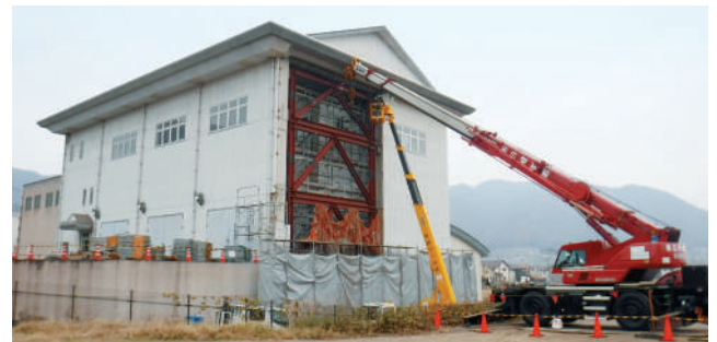
水呑ポンプ場の耐震補強工事
