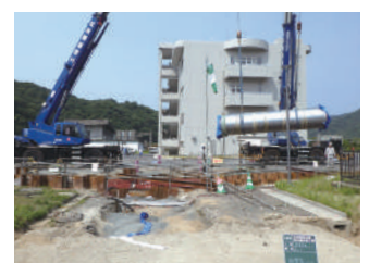
鋼管搬入状況
