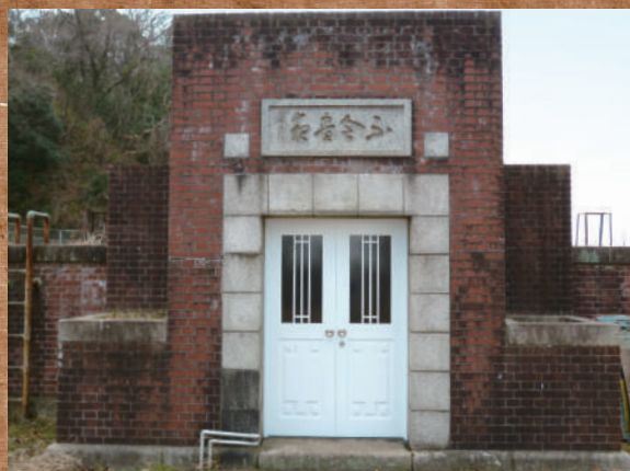
旧佐波浄水場 配水池
