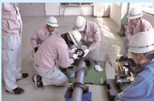
配水管接合研修
