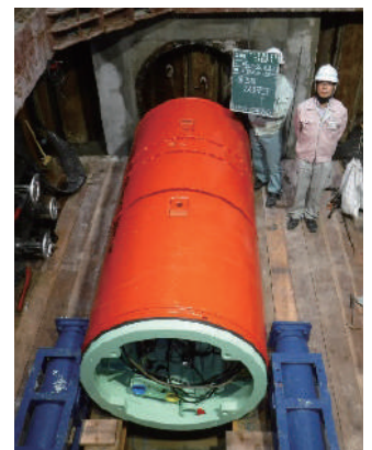
掘削機械(推進機)設置状況
