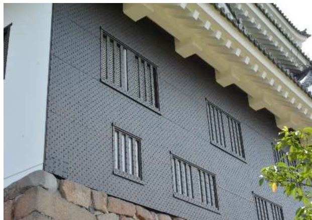
福山城天守北側の鉄板張り
