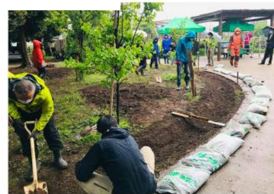
区立次大夫堀公園内里山農園前に雨庭を手づくり中。雨が降った日を観察し、その雨水の流れに沿って、園路沿いに土を掘り、窪地をつくる（画像提供／世田谷トラストまちづくり）
