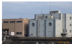
▲大津野ポンプ場
