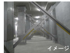
▲耐震化工事の写真
