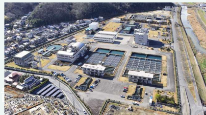
▲中津原浄水場の全景
