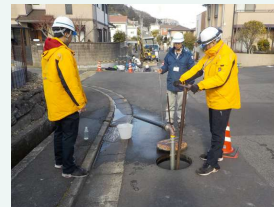
▲中大口径の断水切替作業
