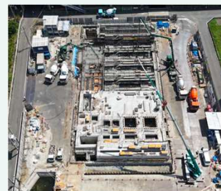
▲建設中の蔵王ポンプ場
