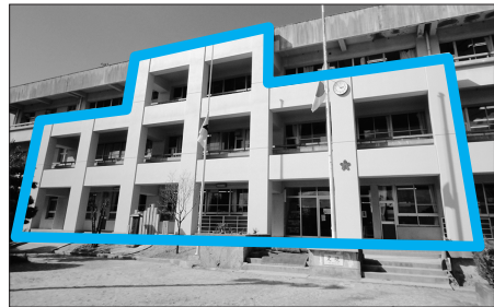
耐震改修工事が完了した網引小学校南棟校舎 (太柱の部分が耐震補強箇所)
