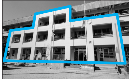
耐震改修工事が完了した網引小学校南棟校舎 (太枠の部分が耐震補強箇所)
