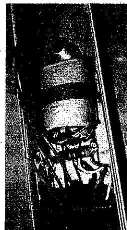
破損した蛍光器具内のコンデンサー＝洞爺湖町教育委員会提供
