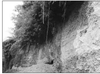
崩れた斜面 (東深津町)
