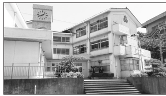
複合施設として改修される旧走島中学校の校舎
