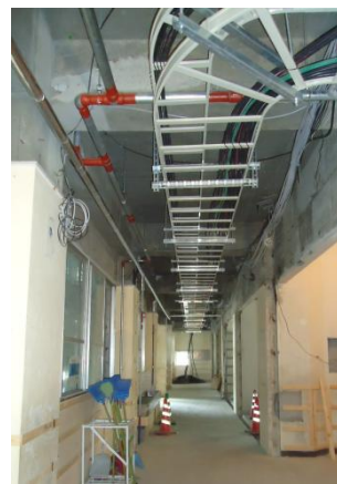
(校舎廊下の天井)
