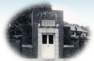
旧佐波浄水場 配水池正門 ※国の登録有形文化財(建造物)
