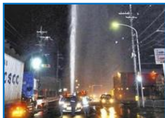
《左図》 水道管の破裂による漏水 ※出典：読売新聞
