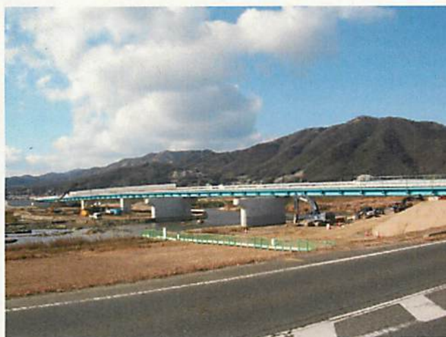
【山手橋の下部工の一部(橋台1基, 橋脚3基)完了】
