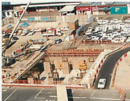
【地下送迎場工事】
