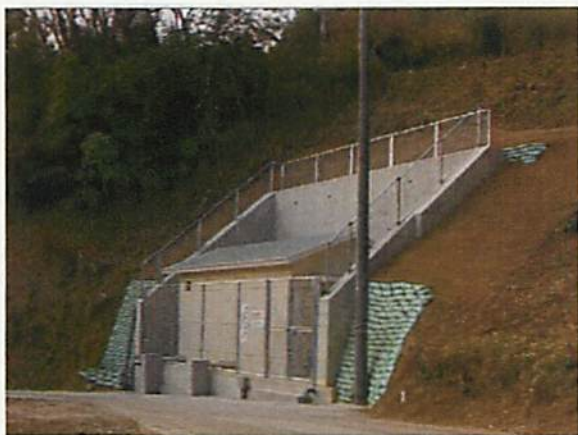
【加圧ポンプ所】
