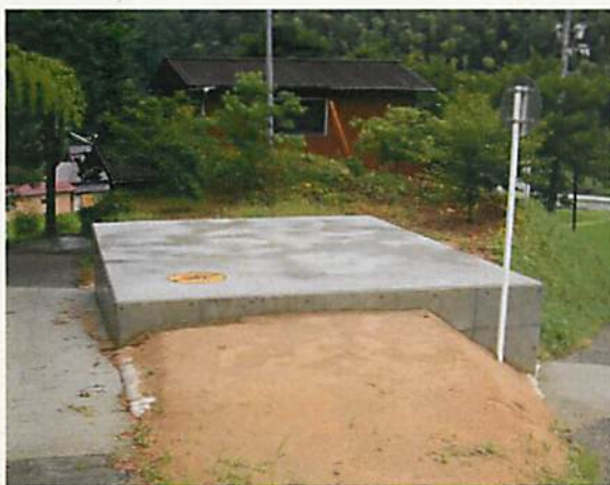
【集落防災安全施設防火水槽(芦田)】
