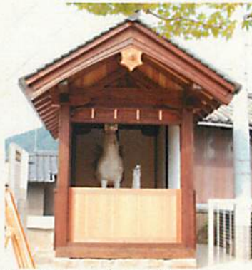
【修理後…屋根瓦など全体をきれいに修理】
