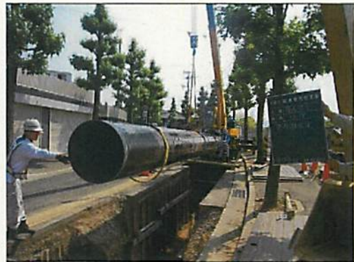
【配水管布設工事(久松台)】
