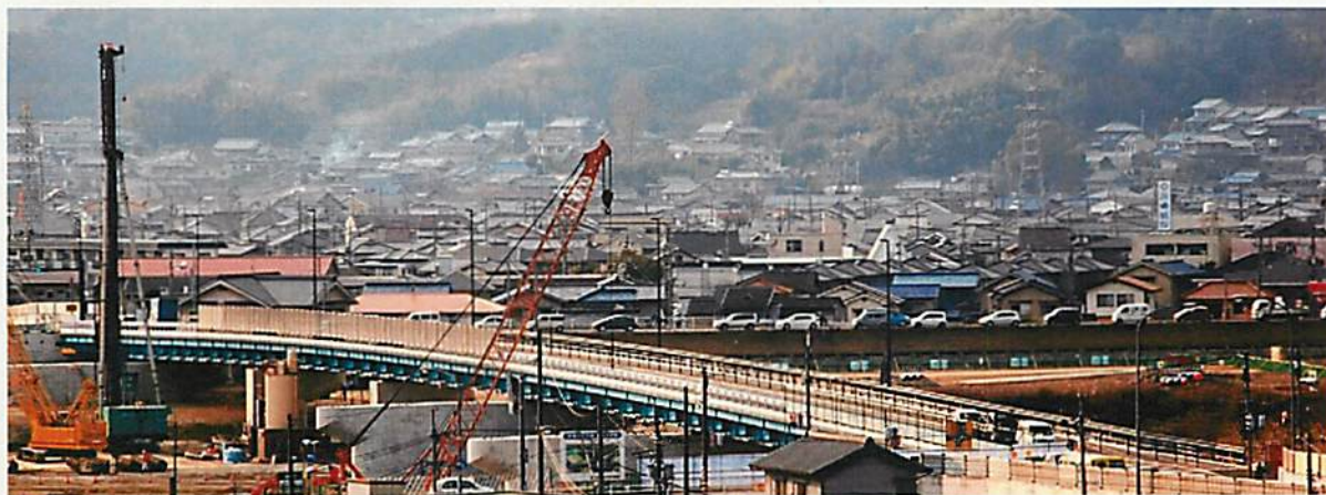
【都市計画道路3・5・614号津之郷奈良津線工事風景】
