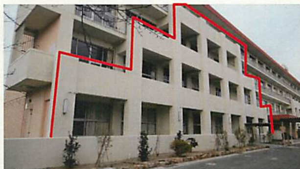
【今津小学校南棟耐震補強工事】
