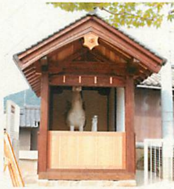
【修理後…屋根瓦など全体をきれいに修理】
