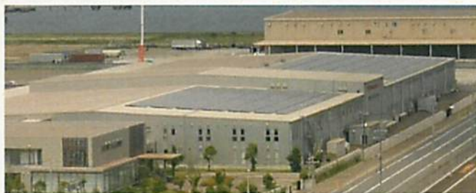
【400kWの事業者用太陽光発電システム】
