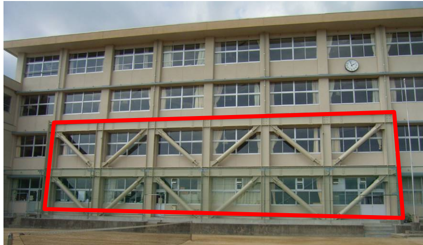
【校舎耐震補強工事イメージ(2010 年度(平成 22 年度)実施か所)】
