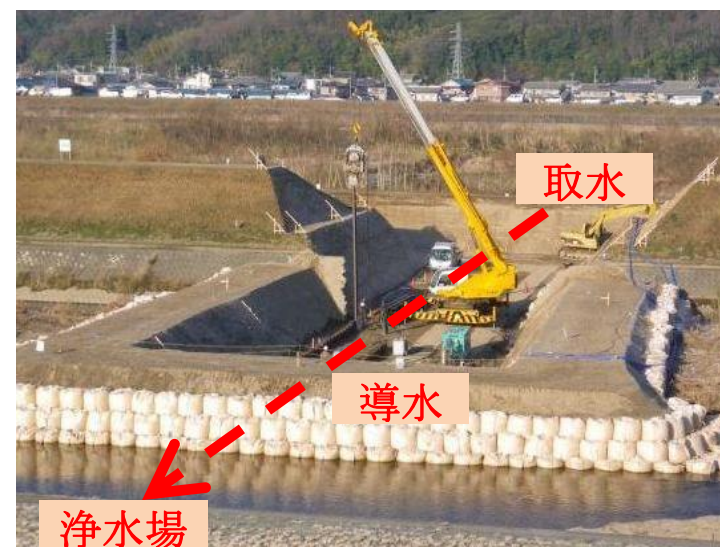
【導水管布設、布設替工事の施工状況】
