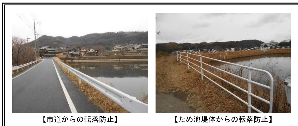
図3-2 ため池 対策状況
