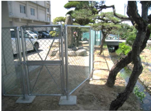
【小学校のフェンス】
