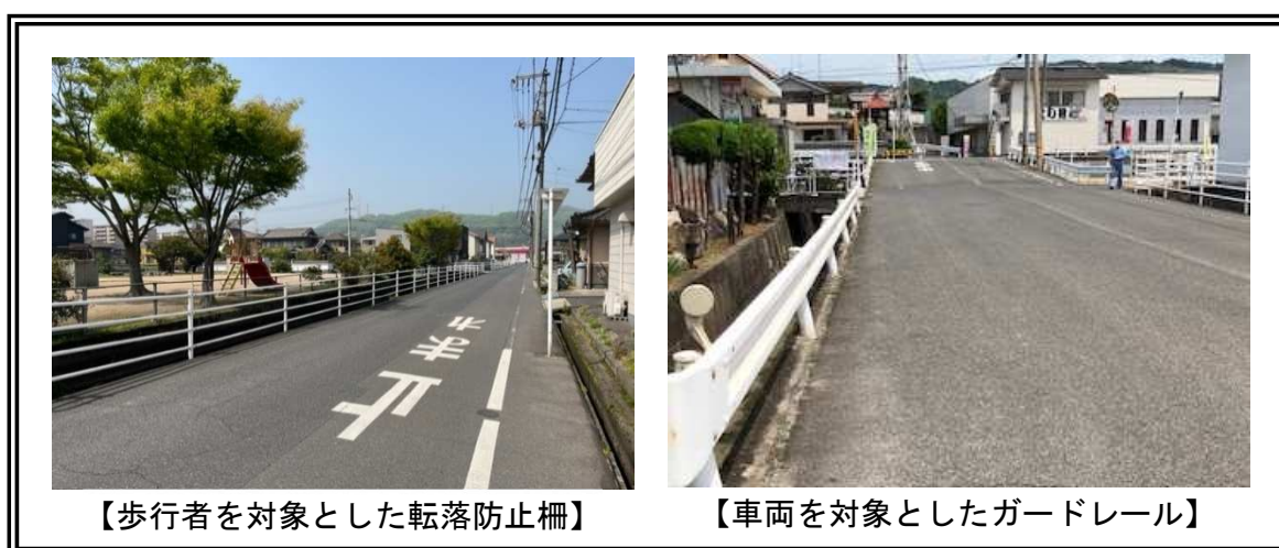
図3-1 道路 対策状況
