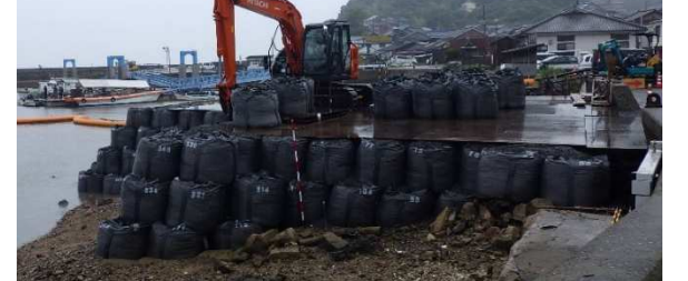
港内作業ヤード設置状況
