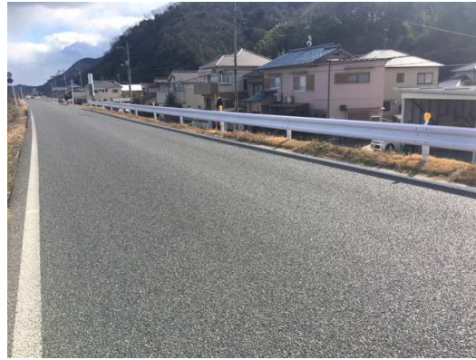
ガードレール
