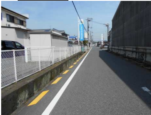
区画線（路肩のカラー化）
