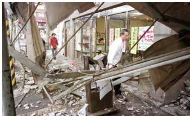
広島市西区 広電 西広島駅付近
