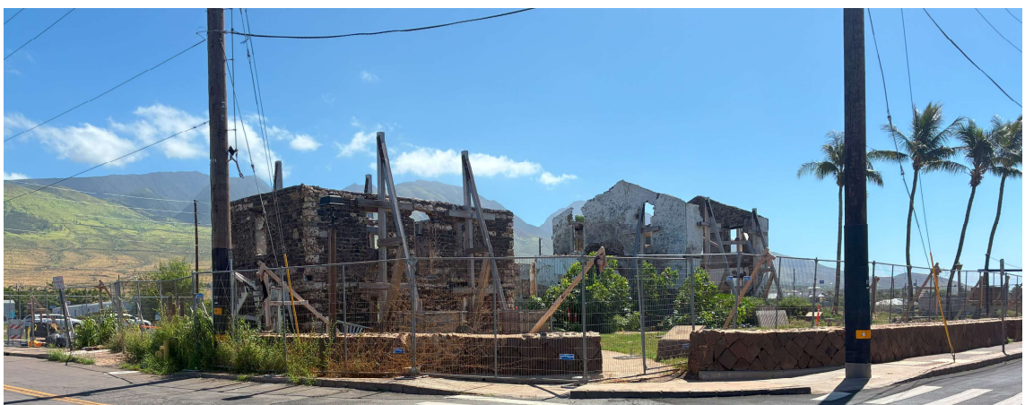
(ラハイナ地区 海岸沿いの被災建物)
