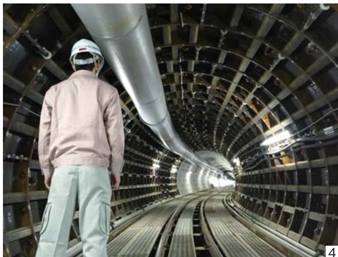
① 中心市街地の雨水を排除する中央ポンプ場 ② 全面更新・耐震化した出原浄水場 ③ 下水道管の耐震化 ④ 浸水被害を軽減する増補管（中央幹線） ⑤ 配水池の耐震化
